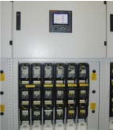
**Datenerfassung in der Verteilung – Messgerät und Gateway in einem.**
