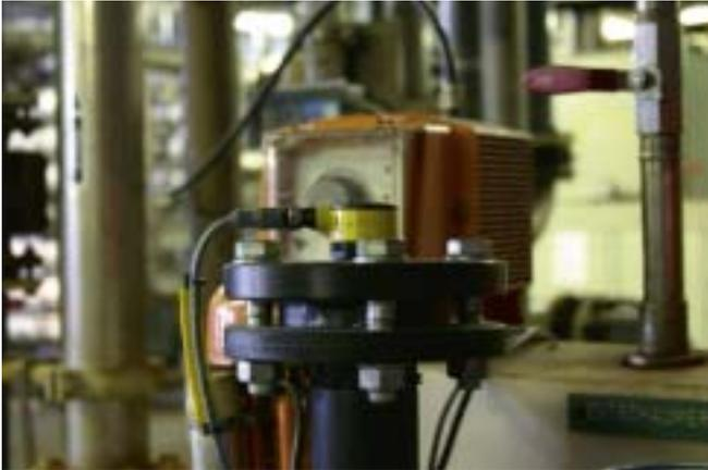
**Turck-Ultraschallsensoren vom Typ Banner T30UUPBQ überwachen den Füllstand von Zusatzstoffen für die Wasseraufbereitung.**
