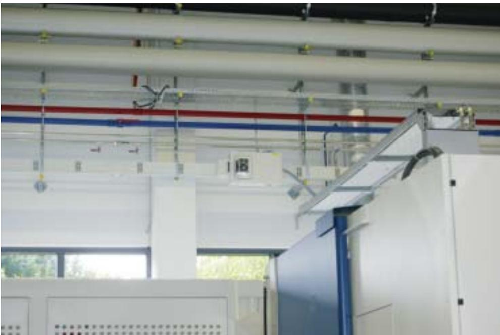
Messen vor Ort – In jedem Abgangskasten des Schienenverteilers.
