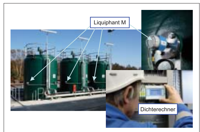
Bild 12: Liquiphant™ M Dichte zur Salz-Konzentrationsmessung, mit Dichterechner.
