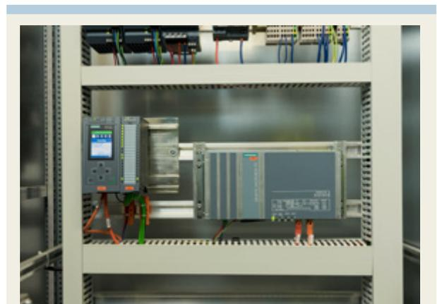
**FÜR DIE ÜBERGEORDNETEN** Anlagensteuerungen der einzelnen Gewerke wurde eine CPU 1516 eingesetzt.
