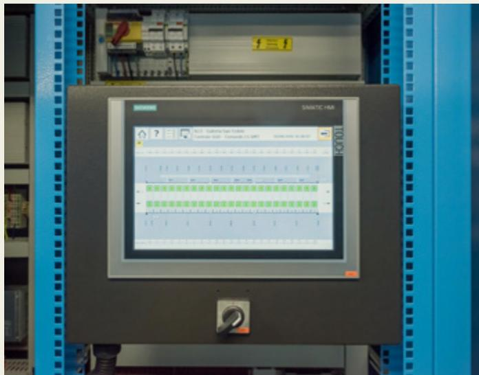
**ÜBER DIE HUMAN MACHINE INTERFACES (HMI) Comfort Touch Panels TP 1200 lässt sich das Leitsystem mit Simatic-Automatisierung einfach bedienen.**
