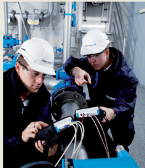
GÜNTER KAULINGFRECKS , Meister Wassernetze bei den Stadtwerken ETO in Telgte, überprüft ein Durchflussmessgerät.
