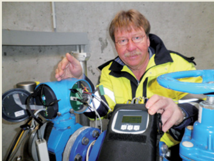
GÜNTER KAULINGFRECKS , Meister Wassernetze bei den Stadtwerken ETO in Telgte, überprüft ein Durchflussmessgerät.
