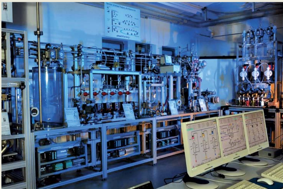
BILD 1: Leitstand mit verfahrenstechnischem Anlagenteil der SmartFactory KL
