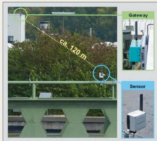
**BILD 2:** Installation auf Räumern mit direkter Sichtverbindung zum Sensorgateway
