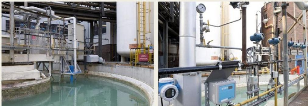
**BILD 3:** Installation auf rotierendem Zyklator für Druck, Durchfluss und Schlammpegelmessung sowie binäre Zustandsabfragen
